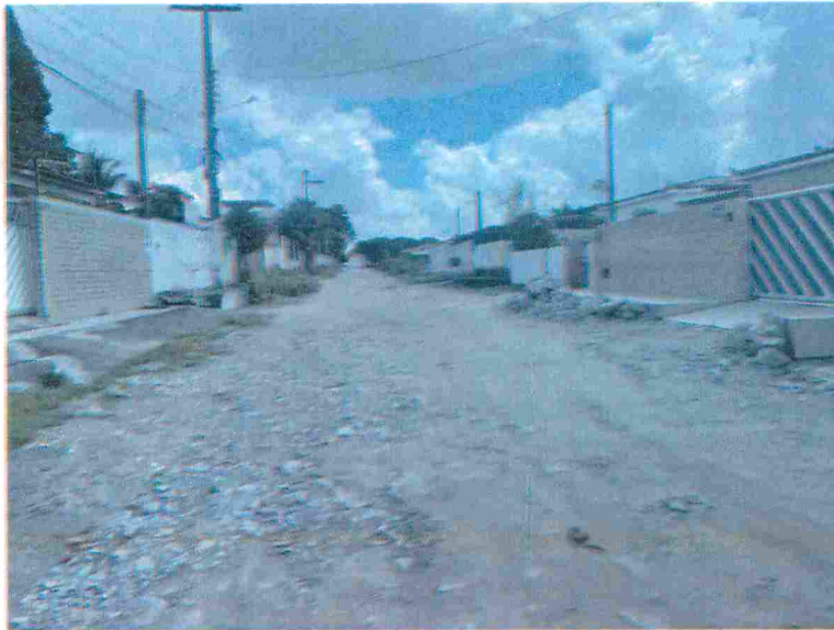
Figura 60 - Rua Sargento Antônio Porto
