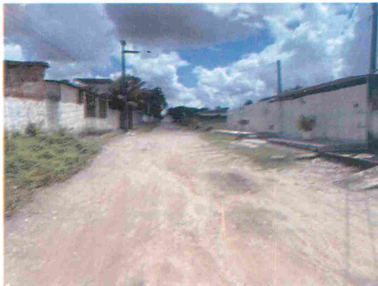
Figura 59 - Rua Sargento Antônio Porto
